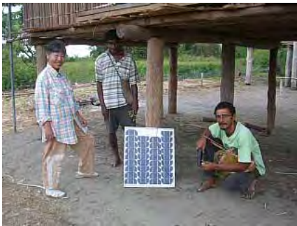
ソーラーネットから寄贈されたパネルを設置
